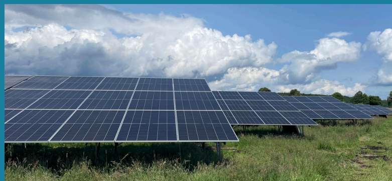
Beispielbilder eines Baufortschritts
